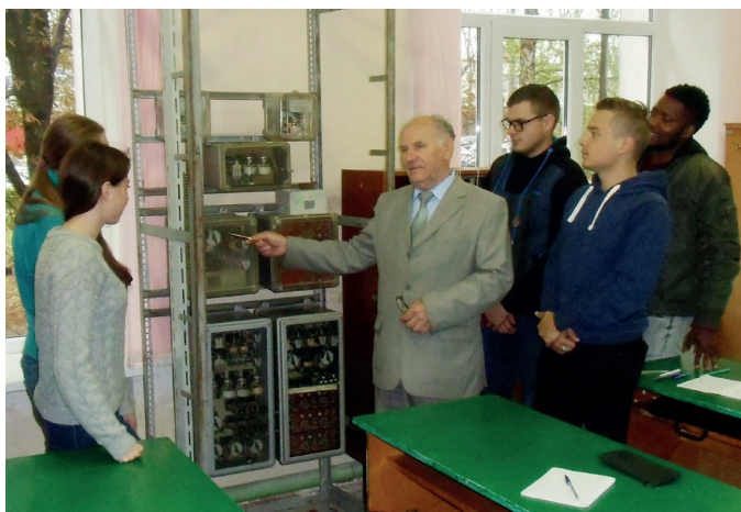
Профессор А. П. Пустовалов объясняет работу автоматики энергосистем
