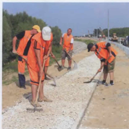
Строительство тратуара на обходе
