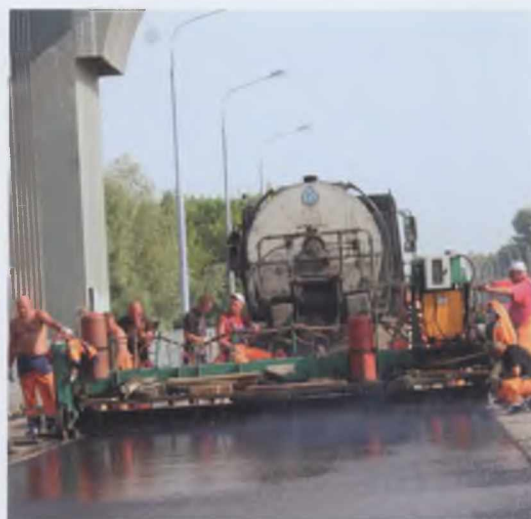
Строительство моста через р. Трубеч
